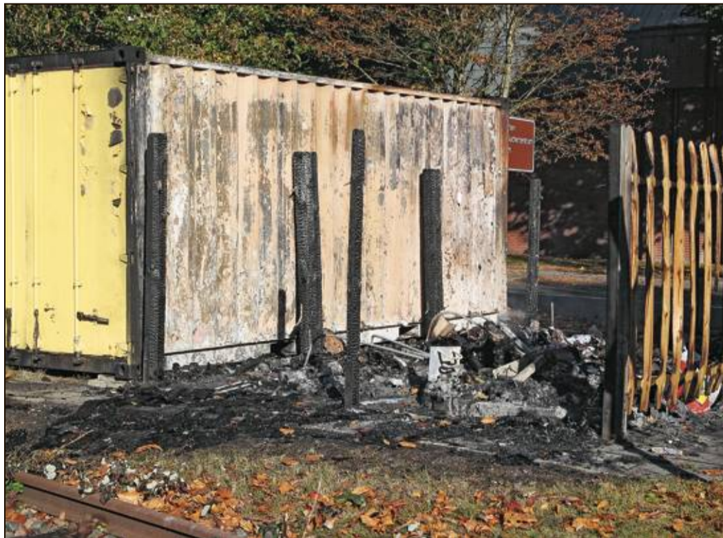
Die Wertstoffcontainer an der Weserstraße/Ecke Jadeallee sind schon zum dritten Mal innerhalb von zwei Monaten niedergebrannt worden.
